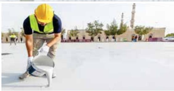
**طلاء لتبريد طرق المشاة:** قامت المملكة باستحداث تقنية لطلاء الأسطح الإسفلتية لطرق المشاعر المقدسة لخفض الحرارة، وتبريد المناخ للدرجات المعتدلة في طرق المشاة الخاصة بالحجاج، ويسهم الطلاء الأبيض في امتصاص درجة حرارة السطح وخفضها بحوالي 30 درجة مئوية.
